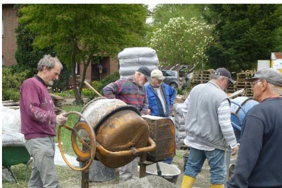
Bevor auf dem Dielenboden „Stampflehm“ aufgetragen werden kann, muss ein Untergrund mit einem Gemisch aus „Blähton“ und „magerem“ Lehm eingebracht werden, auf 60 qm eine ca. 30 cm dicke Schicht. Das erste Bild zeigt diese Arbeit in den letzten Zügen. Dasselbe Gemisch wurde zwischen den rohen Ziegelwänden und einer „verlorenen Schalung“ eingestampft. Alles ergibt eine wirksame Dämmung.
